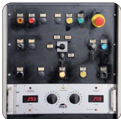
Contrôle de charge intégré à l'armoire de pilotage
