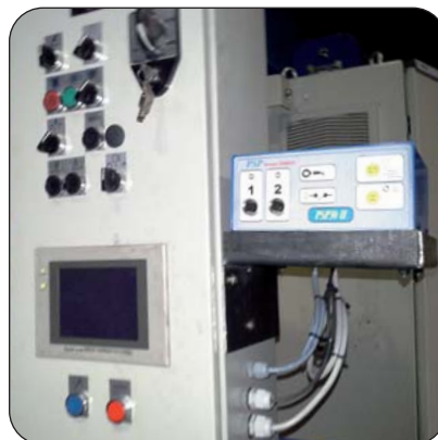
PSP30 en montage externe sur armoire de pilotage
